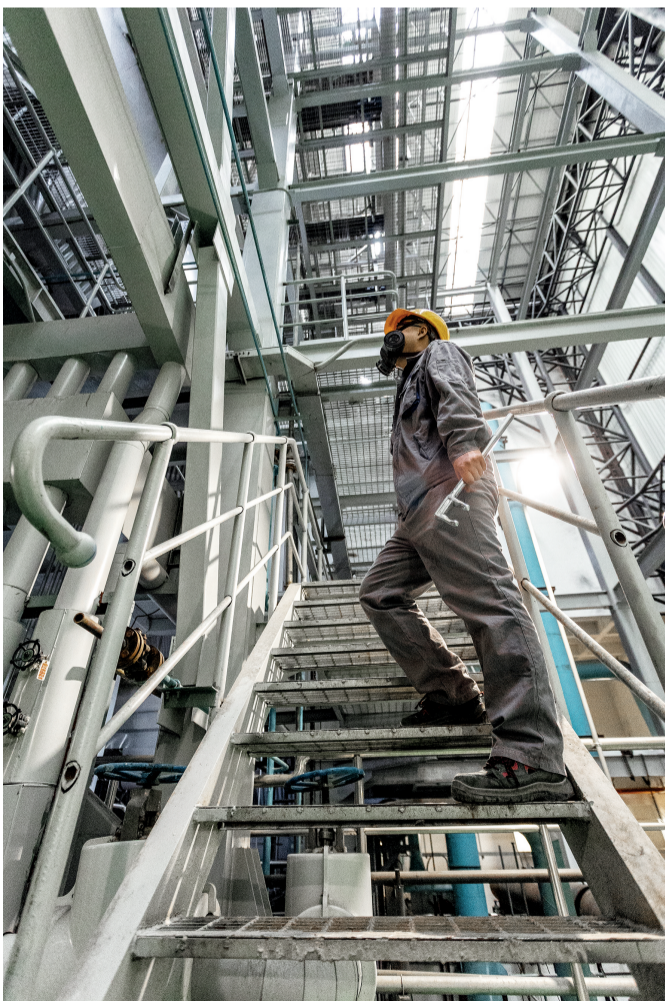
2021年底投入商运的锦州绿能项目,目前机组已安全稳定运行2160小时,计划6月30日前完成各项专项验收及项目整体竣工验收手续。图为公司巡检在做日常检查。 王众摄
